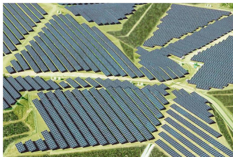
角田市太陽光発電所（WWB 開発）
